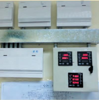
◀ 即時電力監察系統以分析建築工地的能源使用
